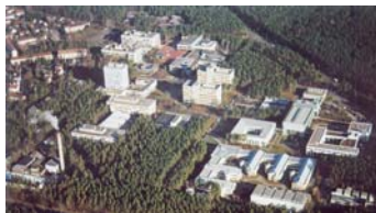
LTM, FAPS, LFT, KTmfk, QFM Technische Fakultät Erlangen, Südgelände
