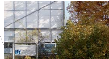
LFT Versuchshalle, Haberstraße 9
