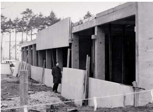
Die Mehrzweckgebäude, in denen der Maschinenbau untergebracht ist, wurden bereits in den 60er Jahren errichtet (Bild: TF)
