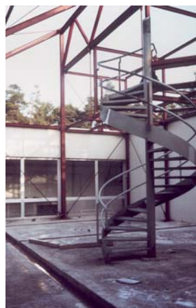
Überdachung des Innenhofs in der Egerlandstr. 5 (1983, Bild: FAPS)
