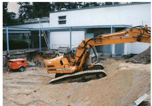
Bau des Messzentrums (Bild: QFM)
